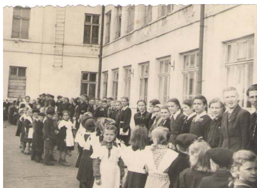
Здание старой школы по ул. К.Маркса
